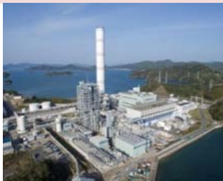
酸素吹IGCC実証試験設備 (広島県・大崎上島)
