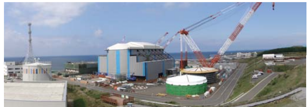
建設状況 (2011年9月現在)
