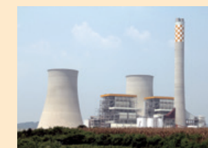
賀州火力発電所(中国)
