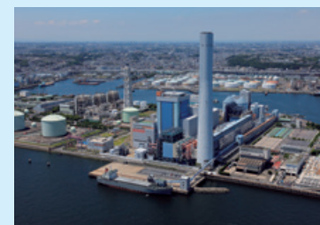
磯子火力発電所(神奈川県横浜市)
