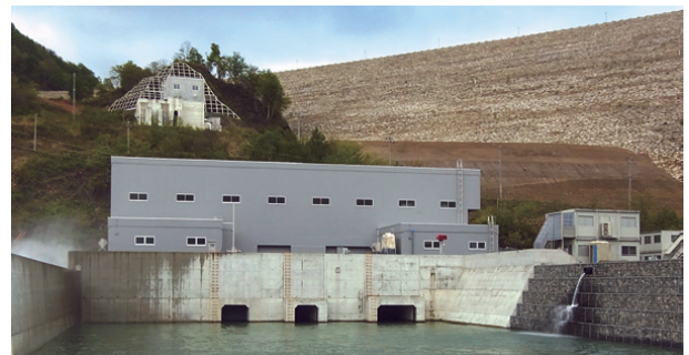
当社第1号の水力発電所である胆沢第一発電所。2014年に、発電効率を高めた大小2機の水車発電機を設置しリニューアル。少ない水量でも効率よく発電できるようになりました。
