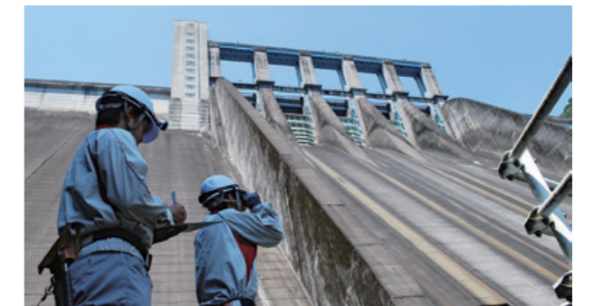
佐久間ダム 巡視点検
