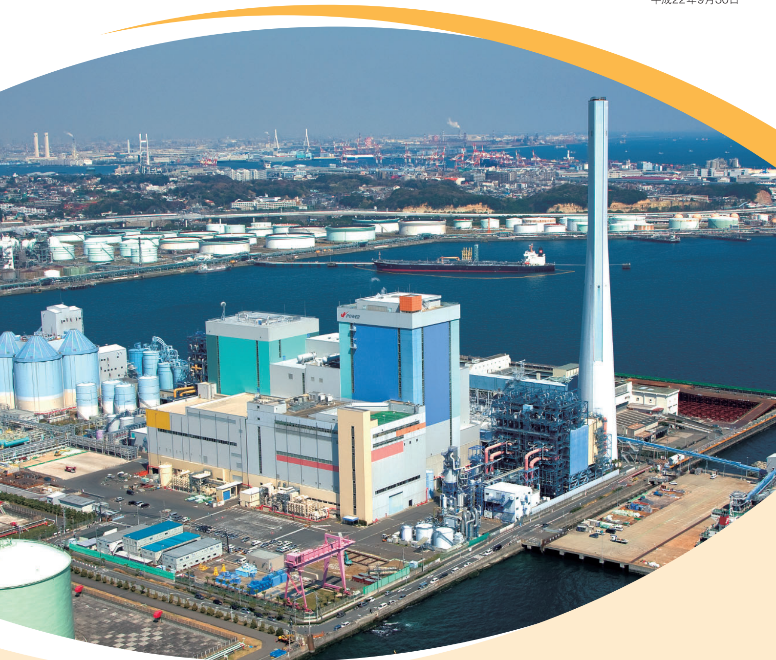
磯子火力発電所(神奈川県横浜市)
