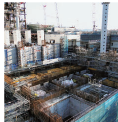
タービン建屋・廃棄物処理建屋
