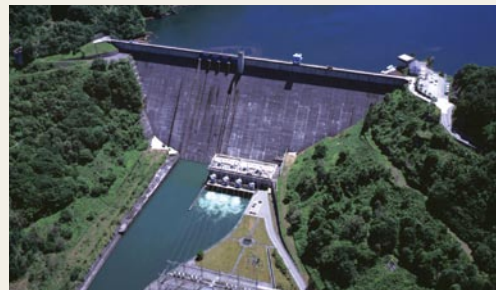
田子倉発電所(福島県)
