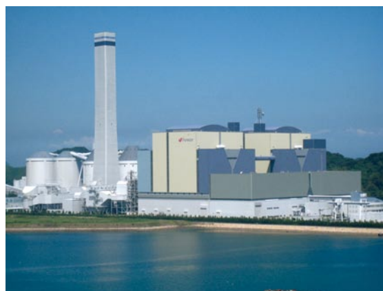
橘湾火力発電所(徳島県)
