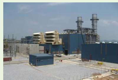
カエンコイ2ガス火力発電所(タイ国)
