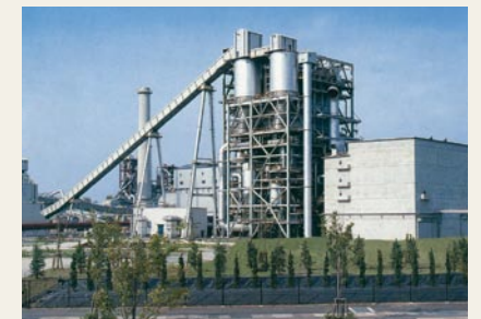
糸魚川発電所(新潟県)
