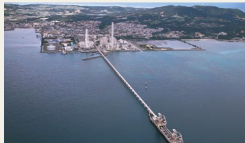
石川石炭火力発電所(沖縄県)
