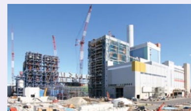
工事中の新2号機
