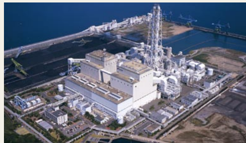
松浦火力発電所(長崎県)
