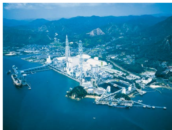
竹原火力発電所(広島県)
