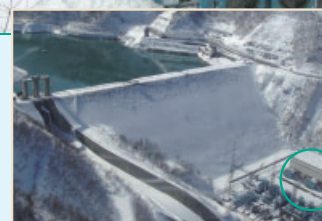
冬の奥清津発電所
