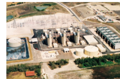
テナスカ・フロンティア発電所
