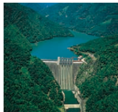
佐久間発電所(静岡県)
