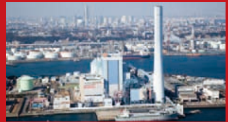
磯子火力発電所(神奈川県)
