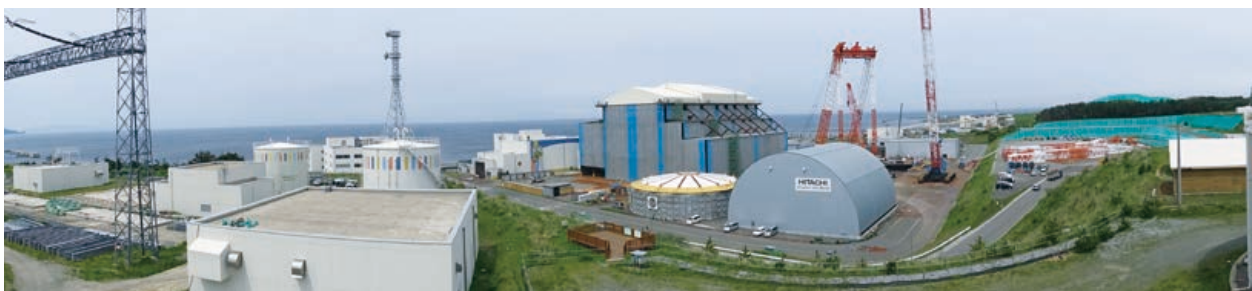
大間原子力発電所の建設状況(2017年6月時点)
