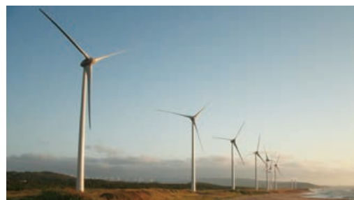
由利本荘海岸風力発電所(秋田県)
