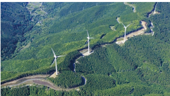
南愛媛風力発電所
