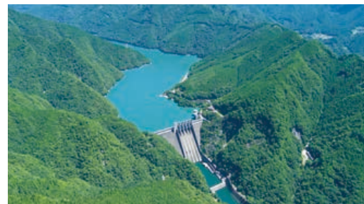
佐久間発電所(静岡県)
