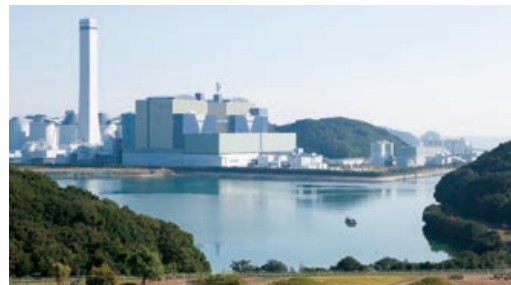
橘湾火力発電所
