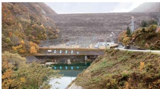
御母衣発電所 (岐阜県)
