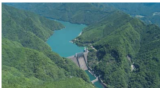
佐久間発電所 (静岡県)
