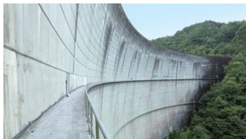
池原発電所 (奈良県)
