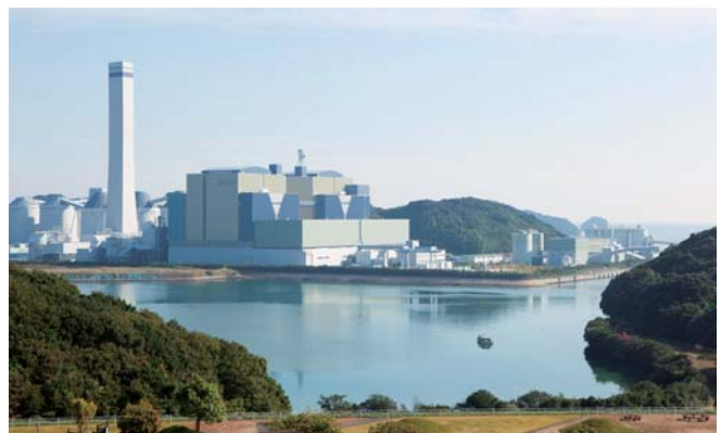
橘湾火力発電所
