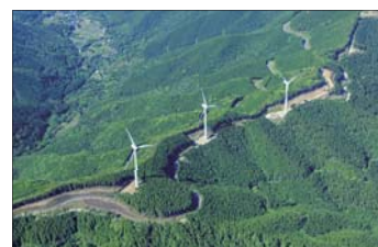
南愛媛風力発電所
