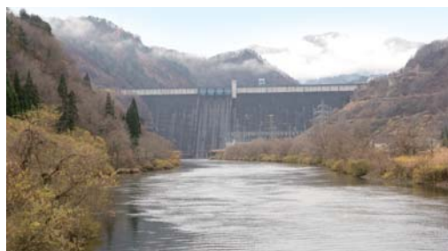
田子倉発電所 (福島県)
