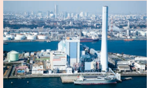
磯子火力発電所(神奈川県)
