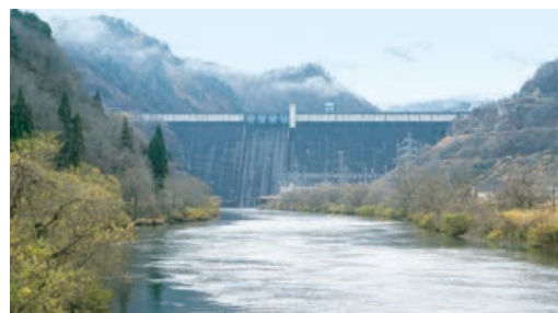
田子倉発電所(福島県)
