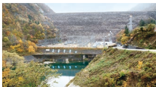
御母衣発電所(岐阜県)
