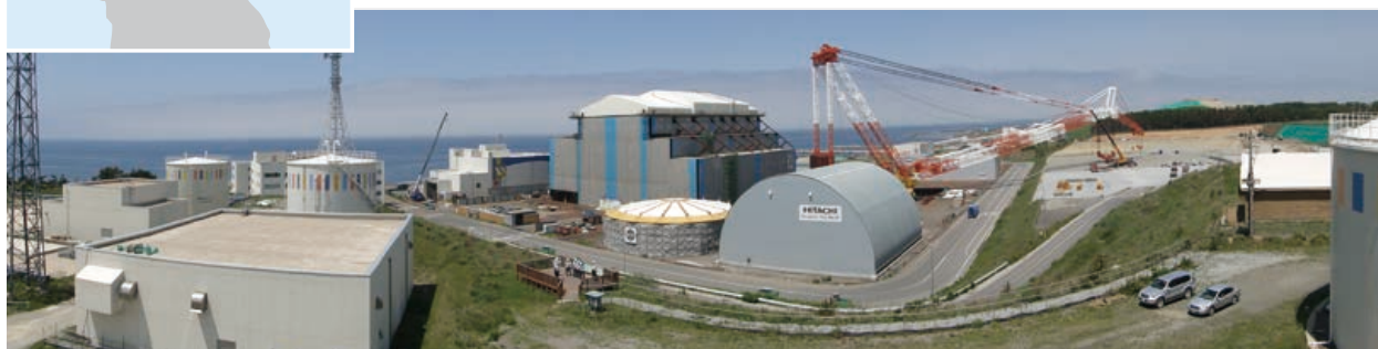
大間原子力発電所の建設状況(2015年7月時点)
