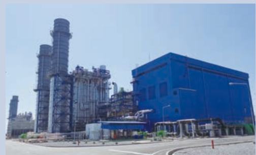
ノンセンガス火力発電所(タイ)
