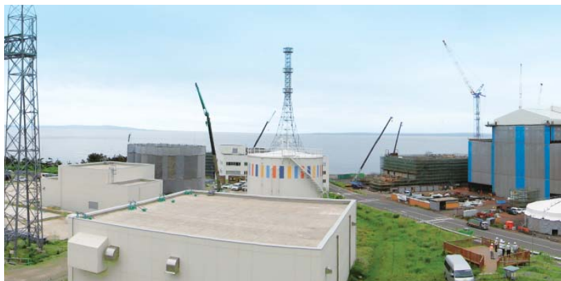
大間原子力発電所の建設状況(2013年6月時点)
