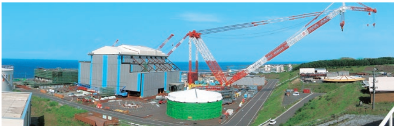
大間原子力発電所の建設状況(2012年8月時点)
