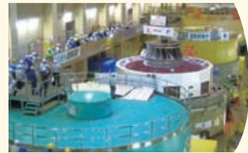
田子倉発電所3号機更新工事
