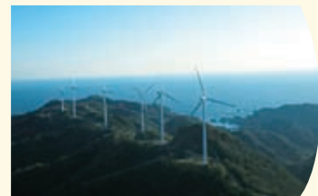
石廊崎風力発電所
