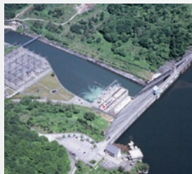
田子倉発電所 (福島県)
