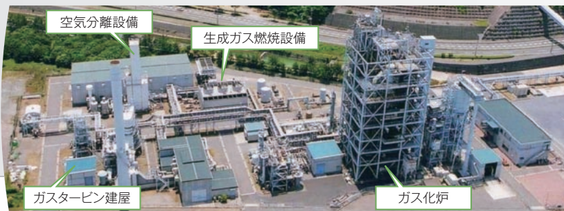
EAGLEパイロット試験設備
