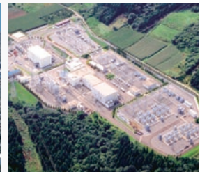
北本連系設備・函館変換所 (北海道)
