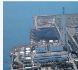
高砂火力発電所 (兵庫県)
