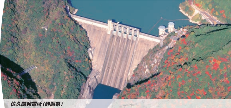
佐久間発電所(静岡県)
