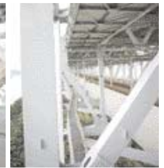
ケーブルの通る添架桁を下から。
