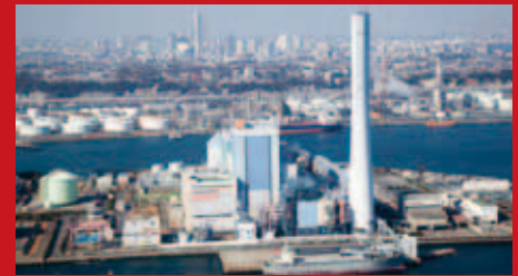
Isogo Thermal Power Plant (Kanagawa Prefecture)
