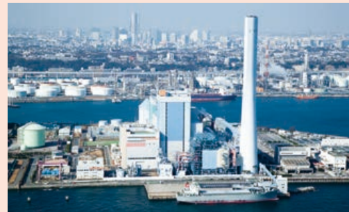
Isogo Thermal Power Plant (Kanagawa Prefecture)
