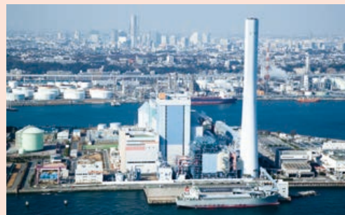
Isogo Thermal Power Plant (Kanagawa Prefecture)
