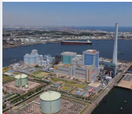
Isogo Thermal Power Plant (Kanagawa Prefecture)
