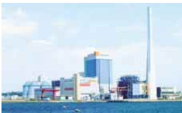
Isogo Thermal Power Station (Kanagawa Prefecture)
