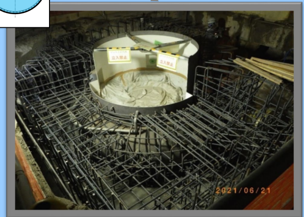
6月-基礎コンクリート打設-
