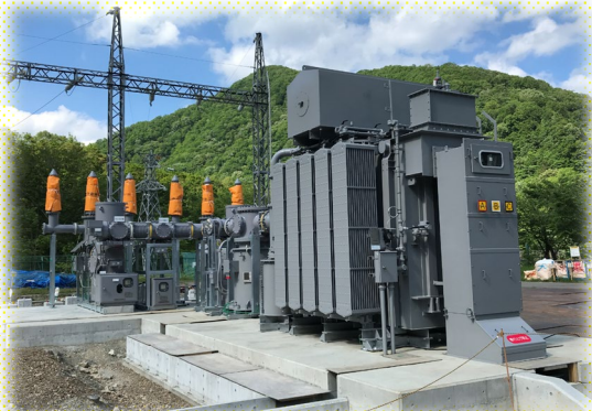
6月-屋外機器据付工事-
