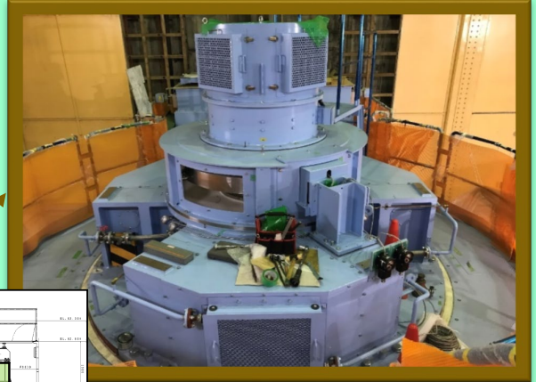
6月-発電機組み立て-
