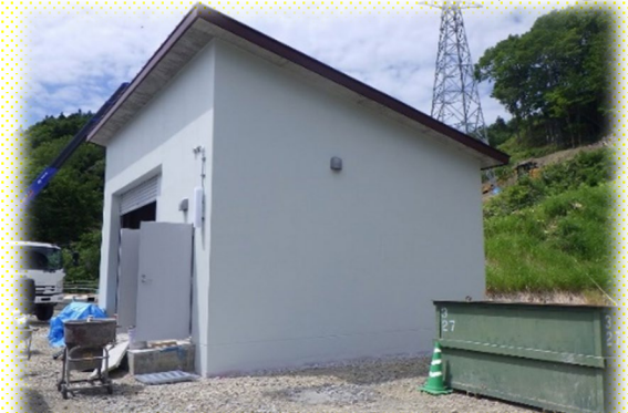
6月-付属設備建築工事-
