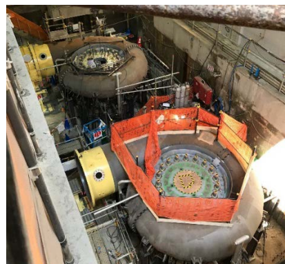
写真② 水車ケーシング据付状況
