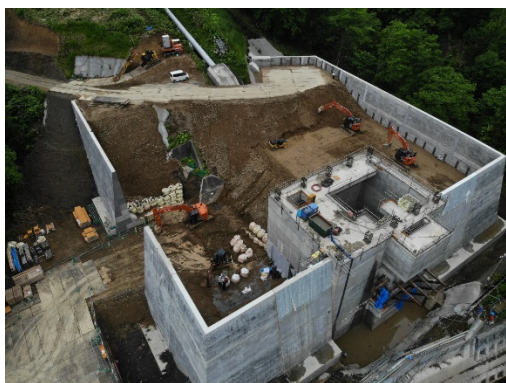
写真① 熊追発電所盛土状況(6月)
