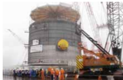
原子炉格納容器下部鋼製ライナの吊り込み
