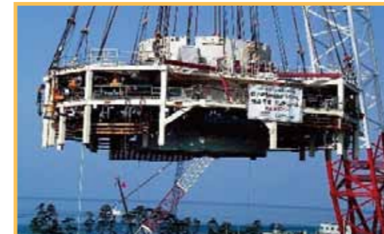
原子炉格納容器内ドライウェルモジュール (写真提供：北陸電力株式会社)
