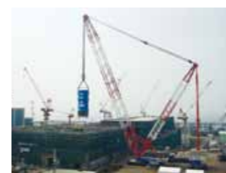
原子炉圧力容器の吊り込み (写真提供:北陸電力株式会社)
