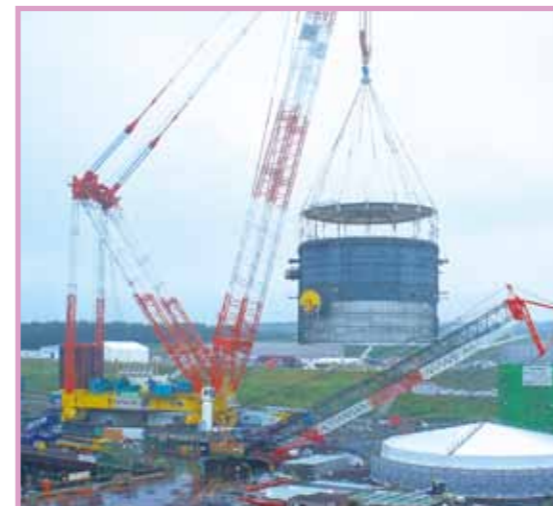
原子炉格納容器下部鋼製ライナ
